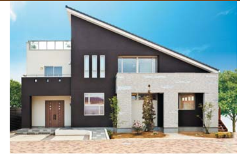
le soleil (木造パネル工法)
